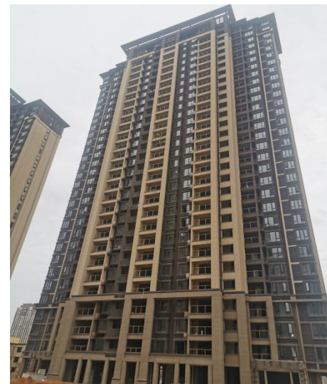
施工后期照片 2
