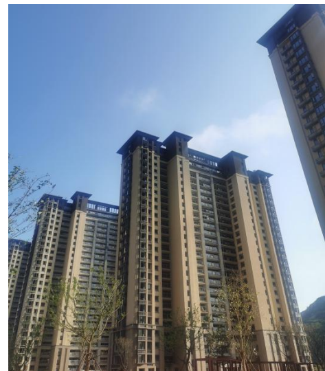
施工后期照片 1
